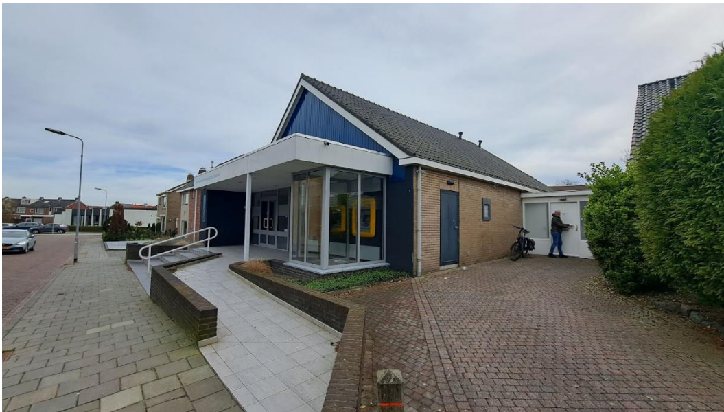
Kantoor WBV Arnhemuiden
